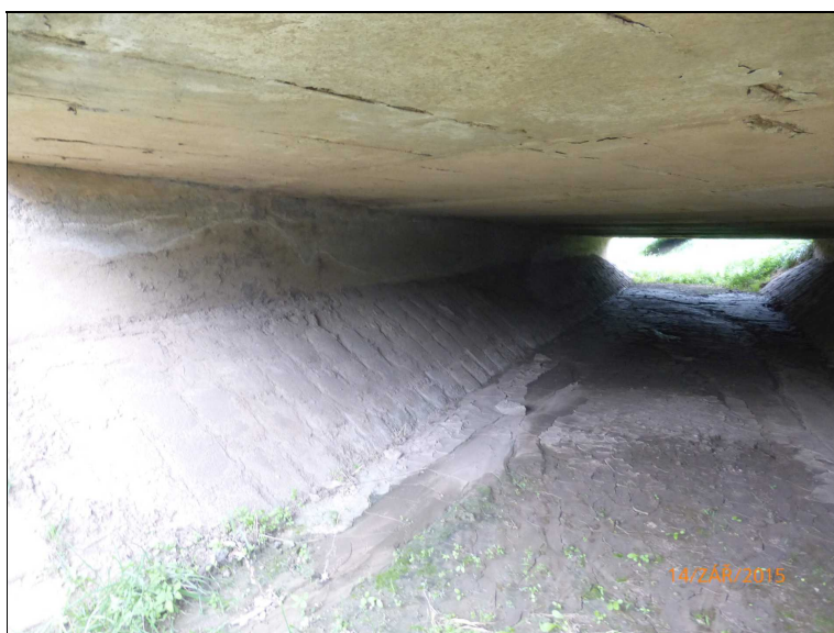
Pohled na opěru 1, podhled nosné konstrukce a stav koryta pod mostem.
