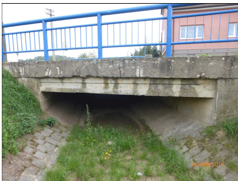
Pohled na most zprava ve směru staničení - zatékání na bok nosné konstrukce, obnažená výztuž říms.
