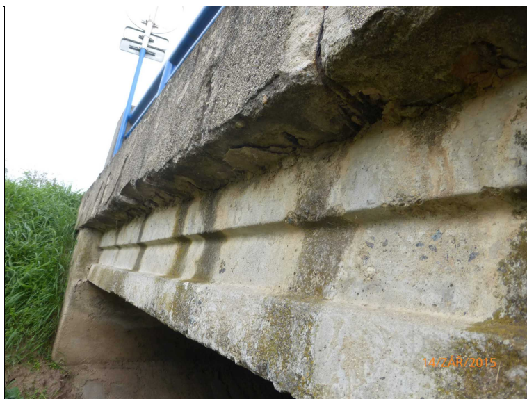
Detail zatékání pod řimsou a na bok nosné konstrukce vpravo na mostě.
