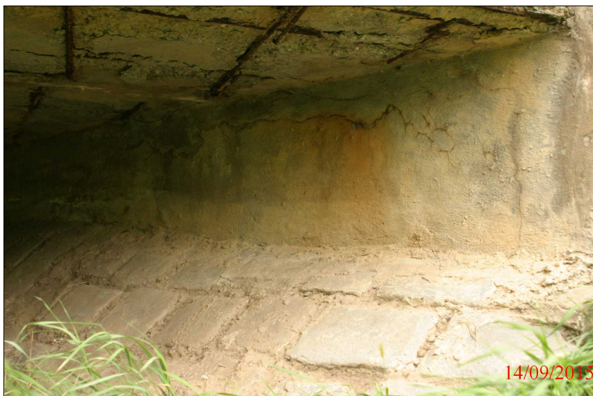
Pohled na levou stranu opěry 1 - trhliny a zatékání, stav krajního nosníku (degradace betonu a koroze bet.výztuže).
