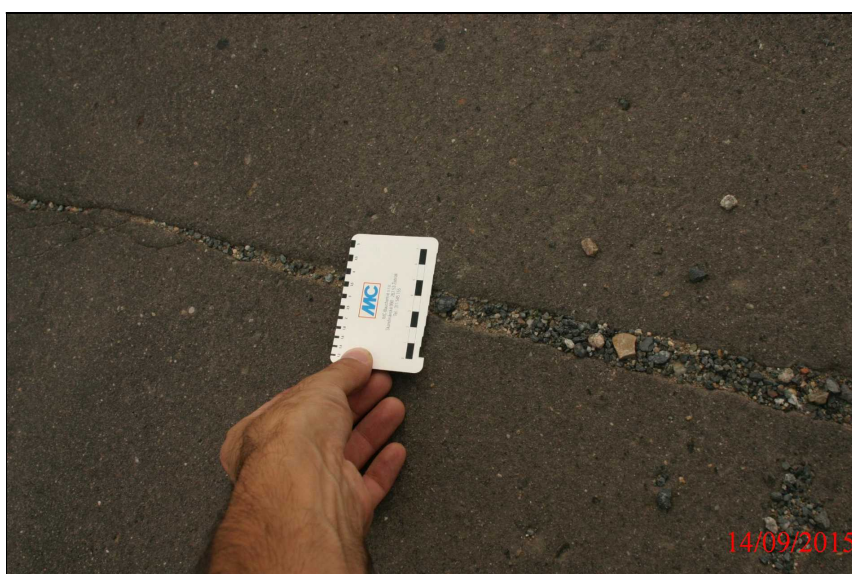
Trhlina ve vozovce
