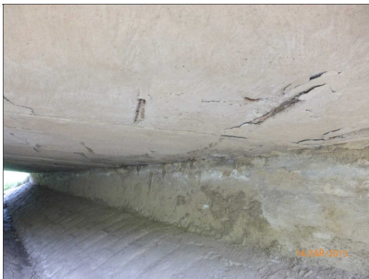
Pohled na opěru 2 a podhled nosné konstrukce - zatékání a výluhy na úložném prahu.
