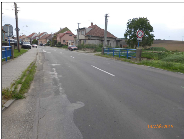
Stav vozovky na mostě, nečistoty a vegetace podél obrubníků.
