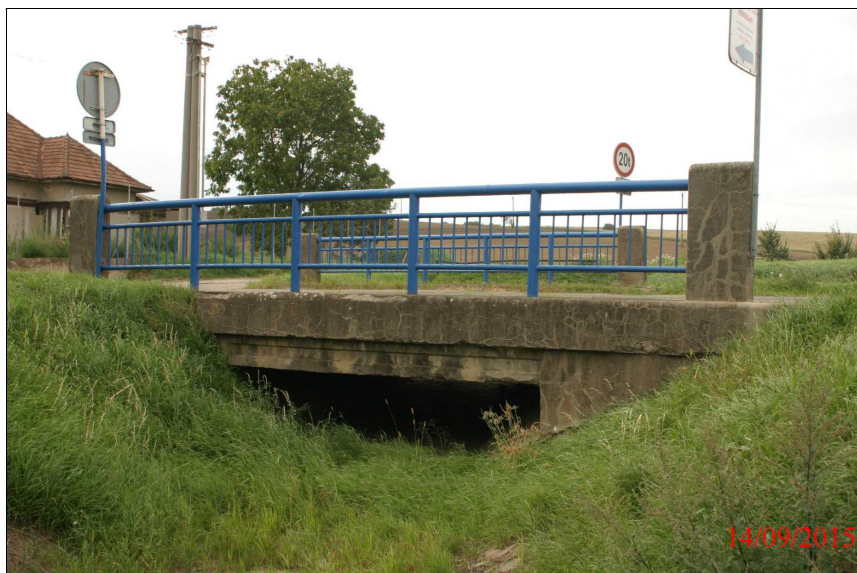
Pohled na most zleva ve směru staničení - poškození boku říms a křídel, zatékání na bok nosné konstrukce
