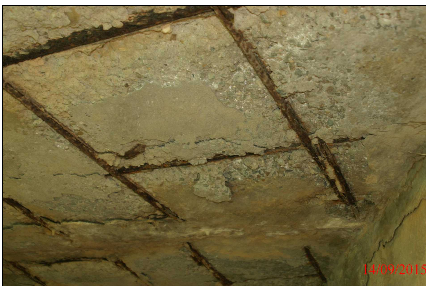
Detail degradace betonu a koroze betonářské výztuže vlevo na mostě u opěry 1
