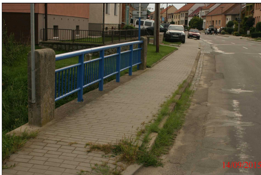
Levá římsa a zábradlí na mostě - vegetace podél obrubníku a stav vozovky na mostě.
