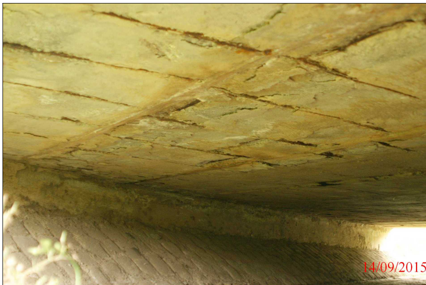
Podhled nosné konstrukce a pohled na opěru 2 - stav spodního líce nosníků, odhalená korodující výztuž a zatékání mezi nosníky.
