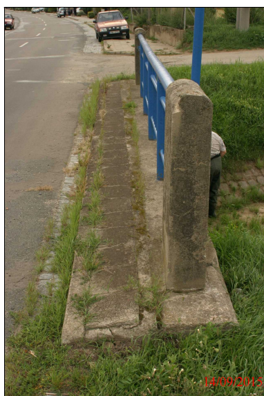
Detailní pohled na pravou římsu na mostě - rozpadající se dlažba a vegetace ve spárách dlažby a podél obrubníku.
