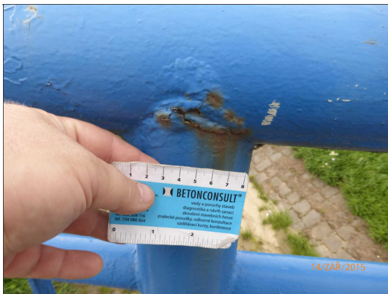
Tyopická porucha ocelového zábradlí na mostě.
